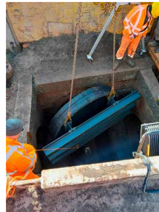
De enorme ijzeren afsluiter die de oude rioolbuis maandenlang veilig afsloot, komt los.
