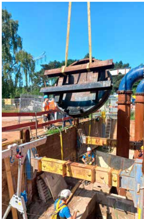
De hijskraan van Heijmans tilt de afsluiter uit de put.
